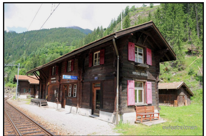
Constructie van dakgoot, regenpijp en dak-lawine-balken.
